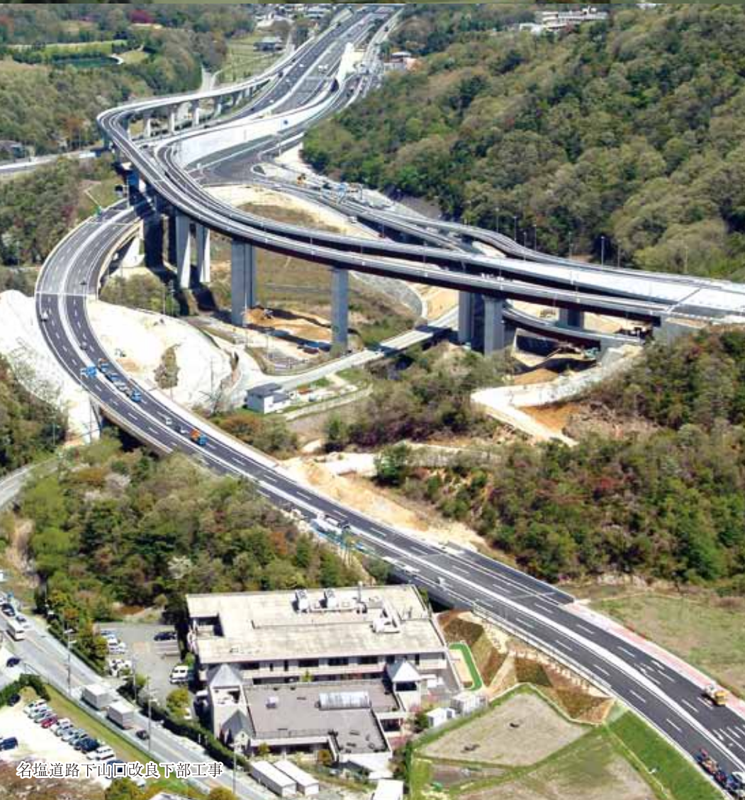
西大阪線延伸工事の内土木工事（第二工区）
