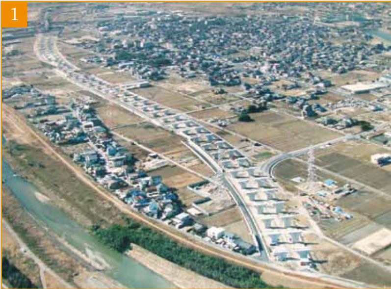
1 第二東名高速道路阿野高架橋 (下部工) 東工事
