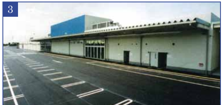
3 ホームセンター小束山店 新築工事
