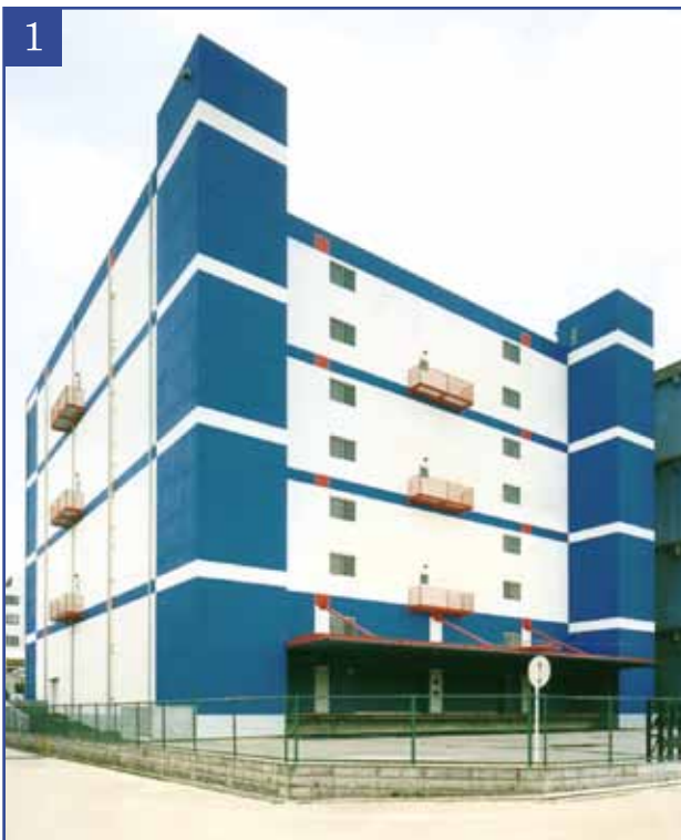
1 共栄倉庫(株)五日市営業所 増築工事
